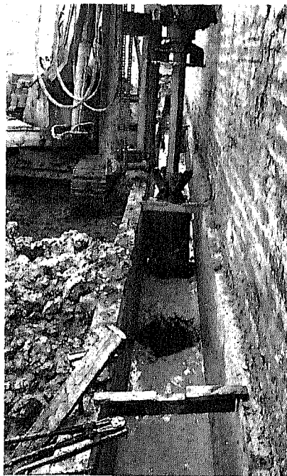
Bild 17. Baggeranbau-bohrgerät BB 6 der Salzgitler Maschinen AG mit Klappschappe bei Perforationsbohrungen für Schlitz
