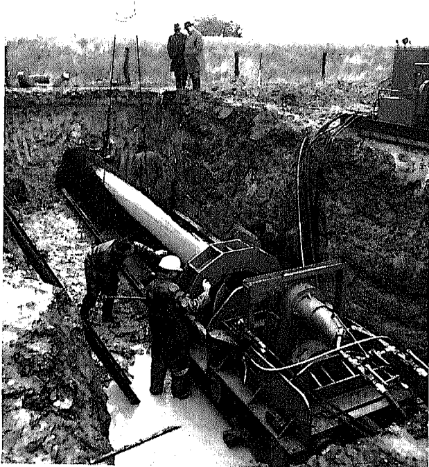
Bild 19. Horizontal-Preßbohranlage 550/5 der Fa. Gebr. Schäfer (Werkfoto: Gebr. Schäfer) Horizontal pressure drilling plant 550/5 of Messrs. Gebr. Schaefer Installation de forage horizontale à pression 550/5 de la maison Gebr. Schäfer Trivellatrice orizzontale a pressione 550/5 della Gebr. Schaefer
