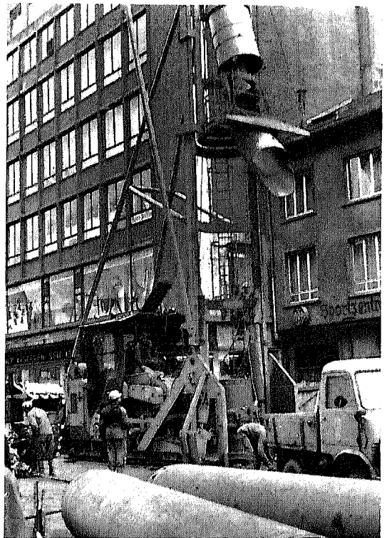
Bild 12. Greiferbohranlage mit Verrohrungsmaschine von Benoto (Werkfoto: SMG )
