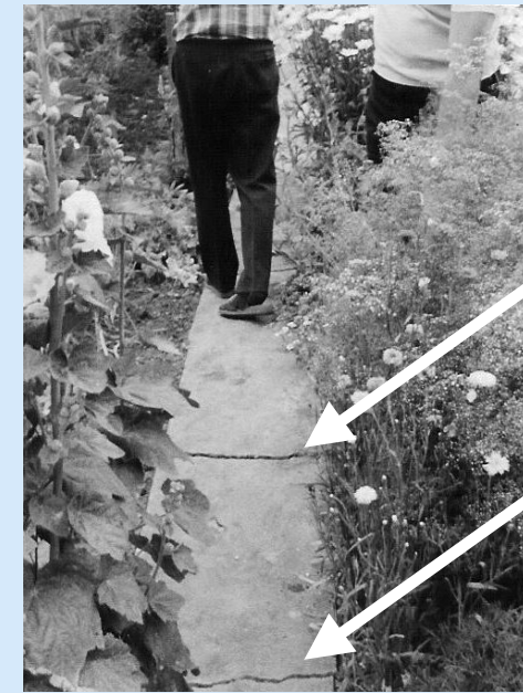
Bodensenkungen als Folge des übermäßigen Sandaustrags
