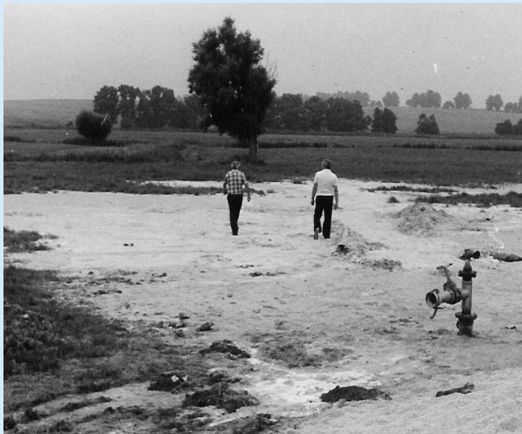
übermäßiger Sandaustrag aus einer Bohrung infolge nicht beherrschter Artesik
