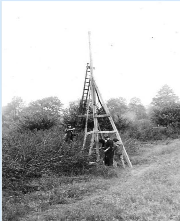
Artesische Grundwassermessstelle mit Hilfsgerüst beim Pumpversuchsmonitoring
