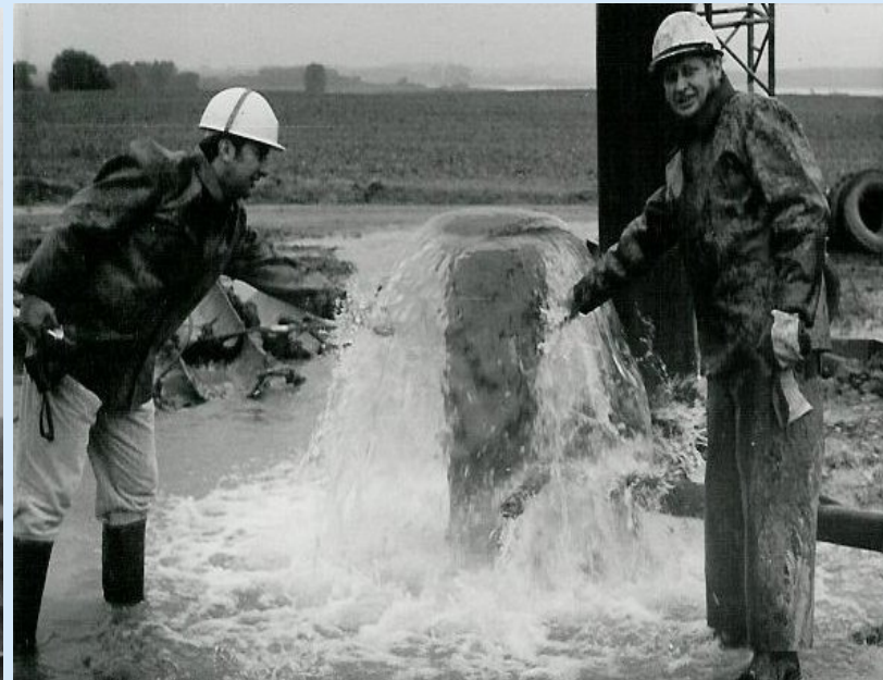
Artesik 14 m ü. Gel., freier Auslauf 160 m 3 /h
