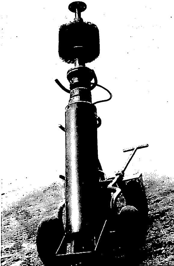
Bild 18: Kombiniertes Reinigungs- und Schlammgerät für Filterbrunnen (VEB BKK Geiseltal)
