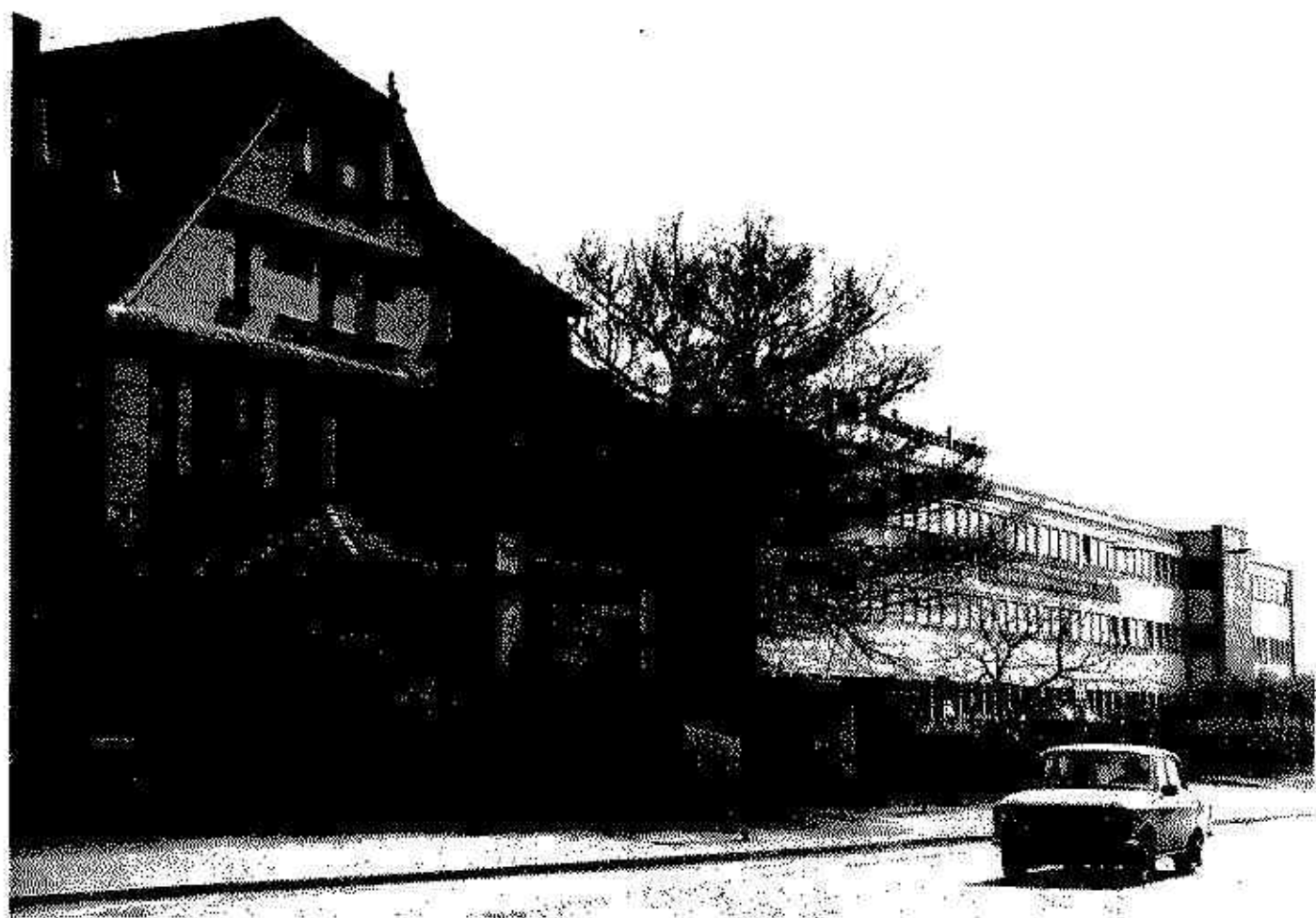
Nordhausen: Straßenansicht auf die Verwaltungs- und Sozialgebäude an der Sondershäuser Straße
