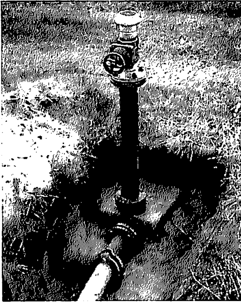
Abb. 34 Endwiderlager mit Hydrant
