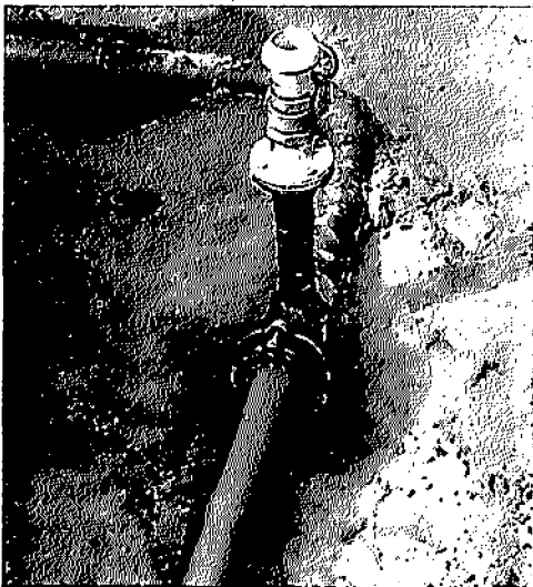
Abb. 26 Einbinden eines selbstgefertigten Bogens mit Entnahmehydranten in eine PVC-hart-Druckrohr- leitung NW 150
