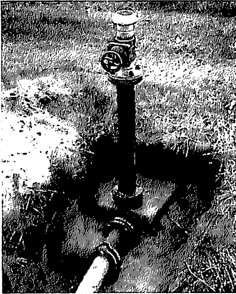
Abb. 34 Endwiderlager mit Hydrant
