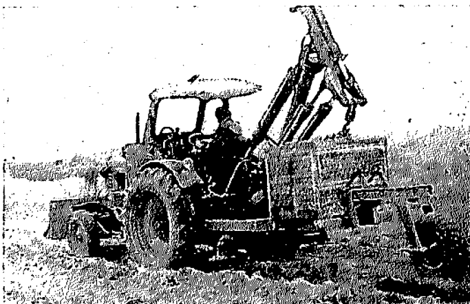
Abb. 79 Umschlag der Dränrohre in Standard- Boxpaletten vom Bau- stellen-Materiallager zu den Drängrabenbaggern
