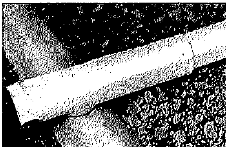
Abb. 9 Sauger-Sammler-Verbindung mit Formstücken aus Plaste bei Tonrohren
