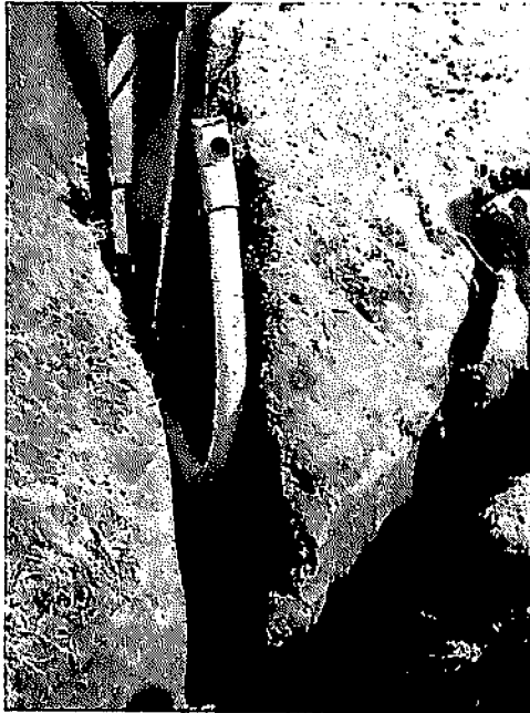
Abb. 86 Verwerfen des verlegten Plastriffelrohres
