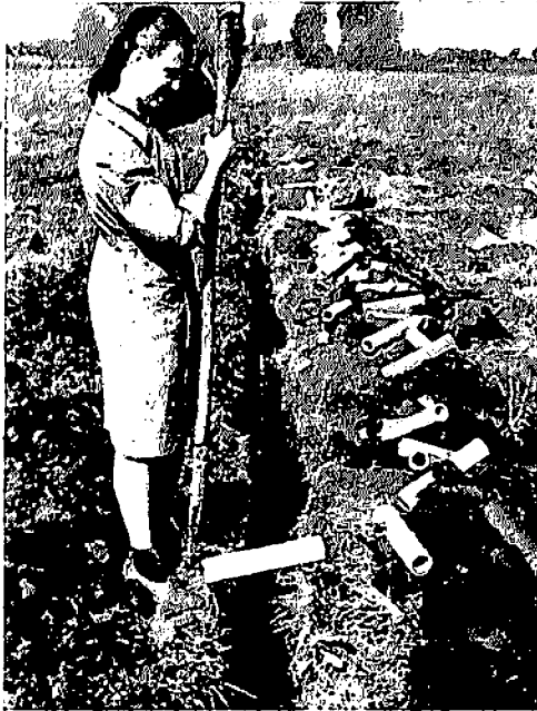
Abb. 106 Verlegen der Dränrohre mit Legehaken
