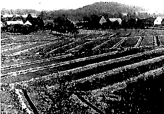
Abb. 45 Volldränung mit mehreren Dränabteilungen
