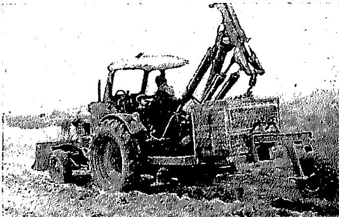
Abb. 79 Umschlag der Dränrohre in Standard- Boxpaletten vom Bau- stellen-Materiallager zu den Drängrabenbaggern
