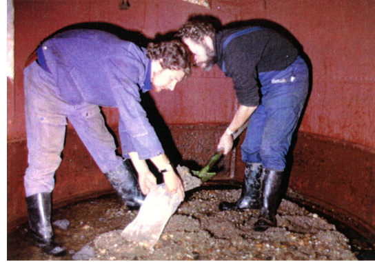
Abb.2: Arbeiten auf der Elbsohle Raum Torgau
